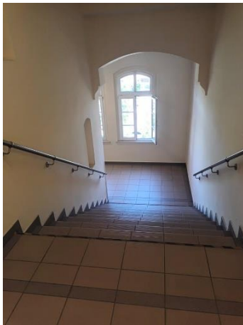
Zdjęcie 5 Klatka schodowa w budynku Sądu Rejonowego w Opolu
