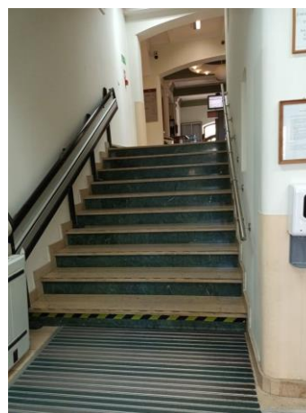
Zdjęcie 2 Schody za wejściem głównym do budynku Sądu Rejonowego w Opolu
