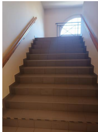
Zdjęcie 6 Klatka schodowa w budynku Sądu Rejonowego w Opolu
