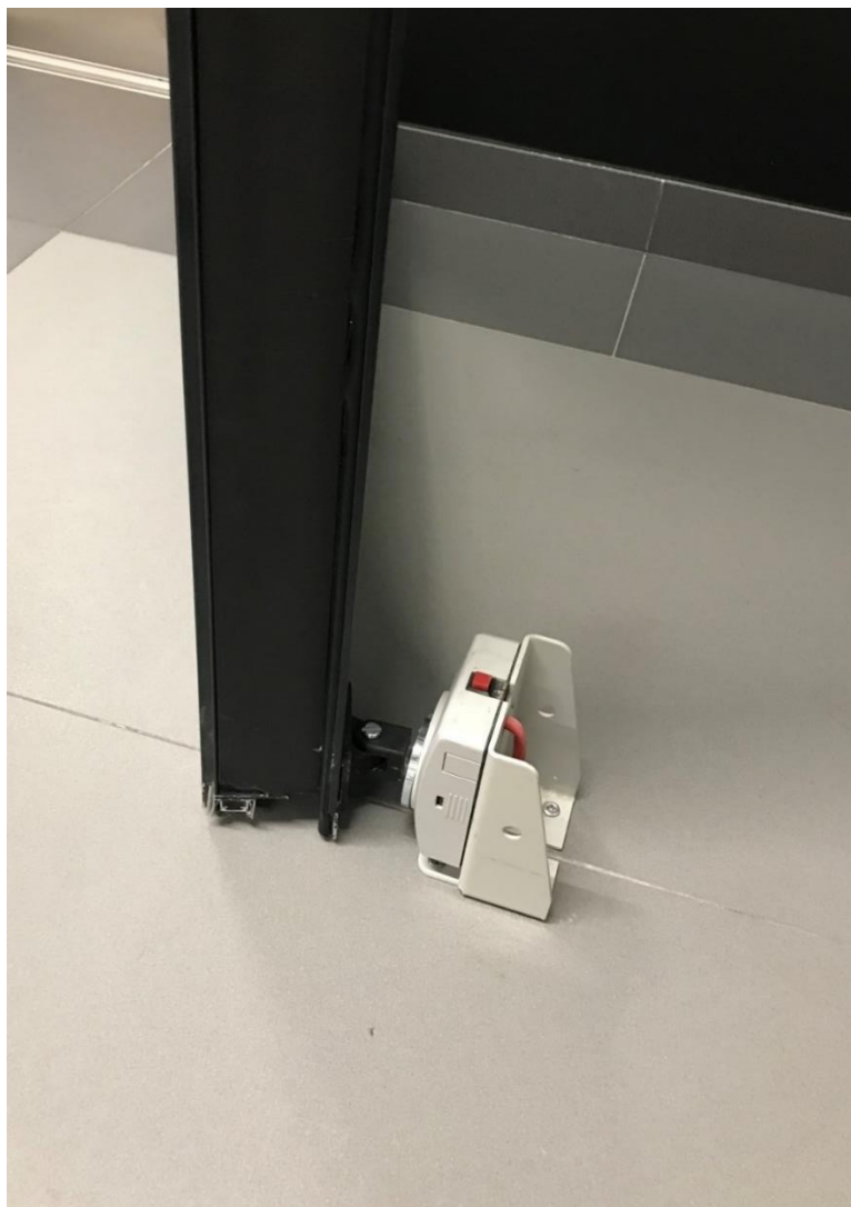
Zdjęcie nr 8 – urządzenie przytrzymujące drzwi w pozycji otwartej.
