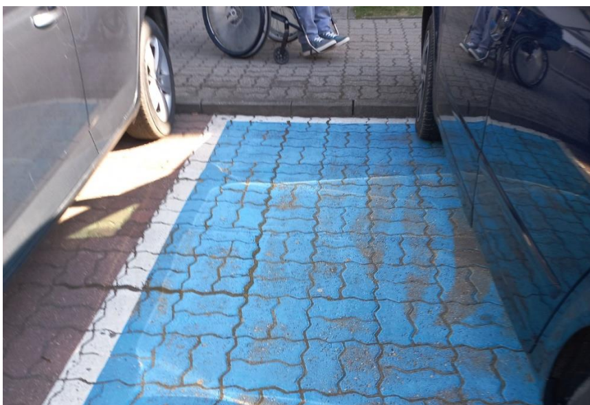
Zdjęcie nr 1 – Miejsce parkingowe dla osób z niepełnosprawnościami – kolorystyka podłoża.
