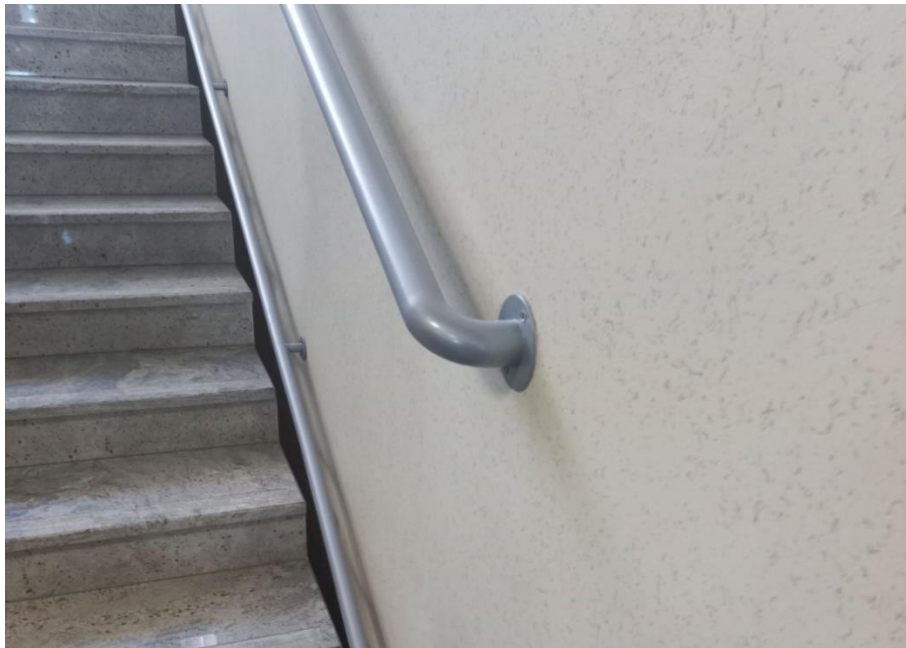
Zdjęcie nr 11 – Poręcz przy schodach wewnętrznej klatki schodowej.
