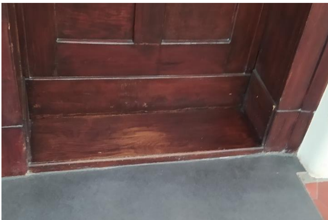
Zdjęcie 11 Progi wewnętrzne w budynku sądu.
