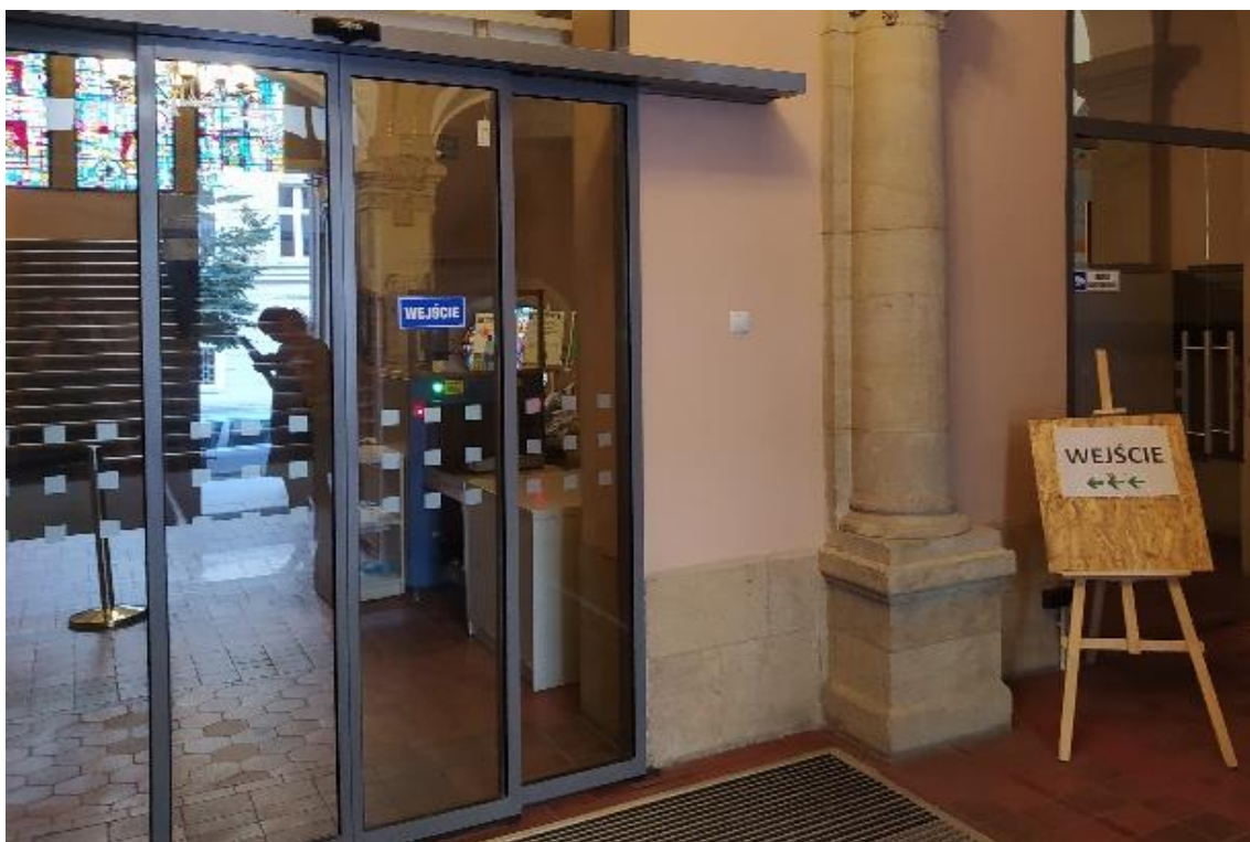
Zdjęcie 3 Przeszklenia przy głównym wejściu do budynku.
