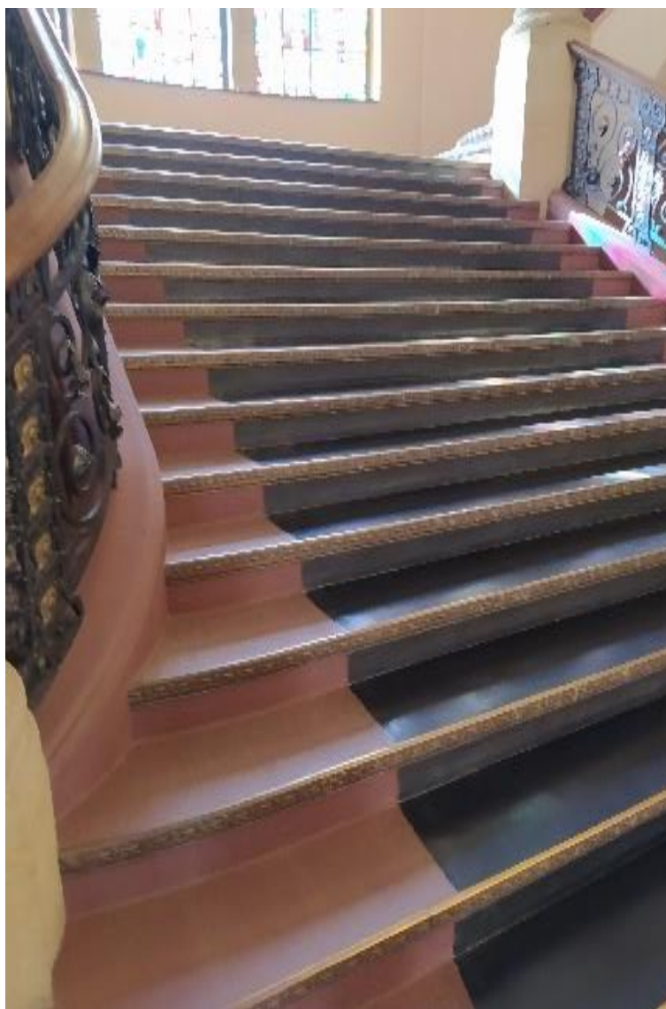
Zdjęcie 6 Schody naprzeciwko wejścia głównego do budynku.
