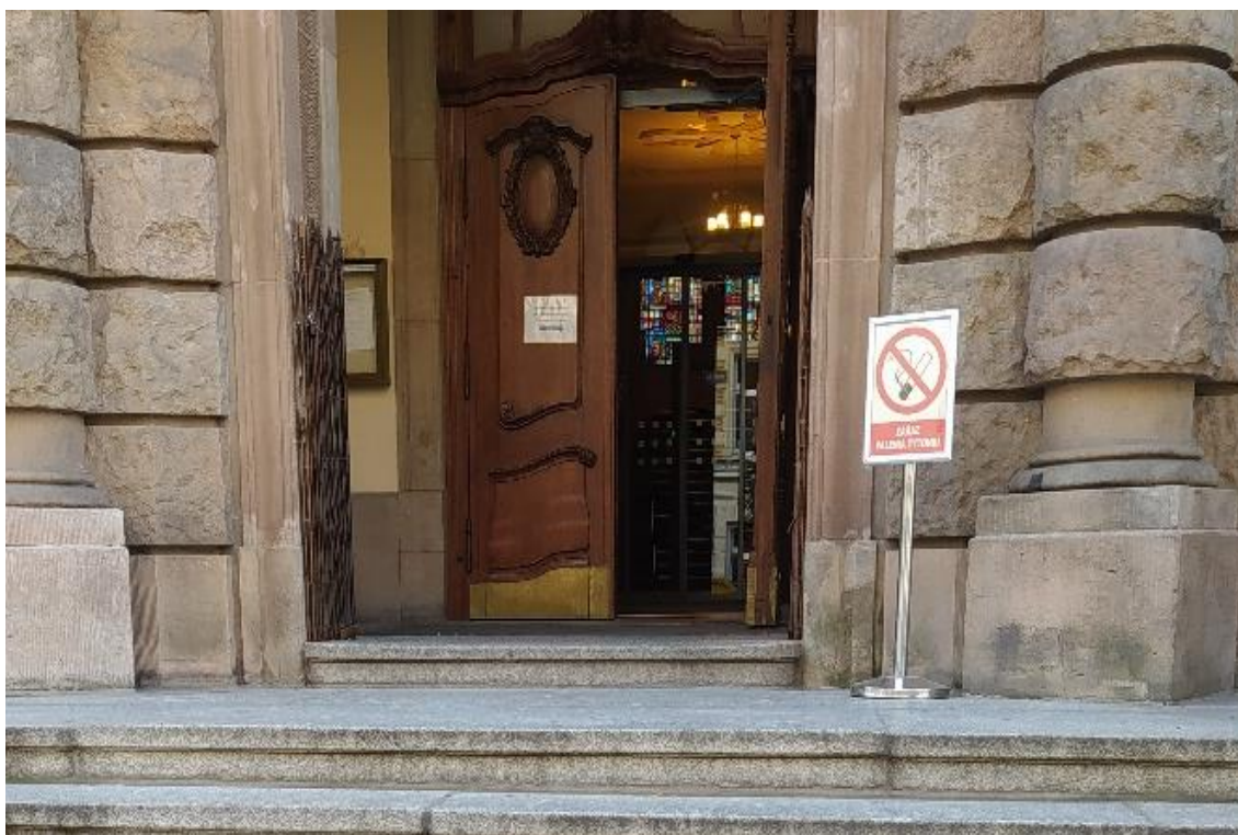
Zdjęcie 2 Główne wejście do budynku.
