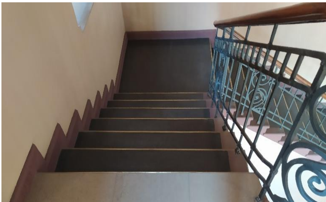
Zdjęcie 7 Schody w tylnej części budynku sądu.
