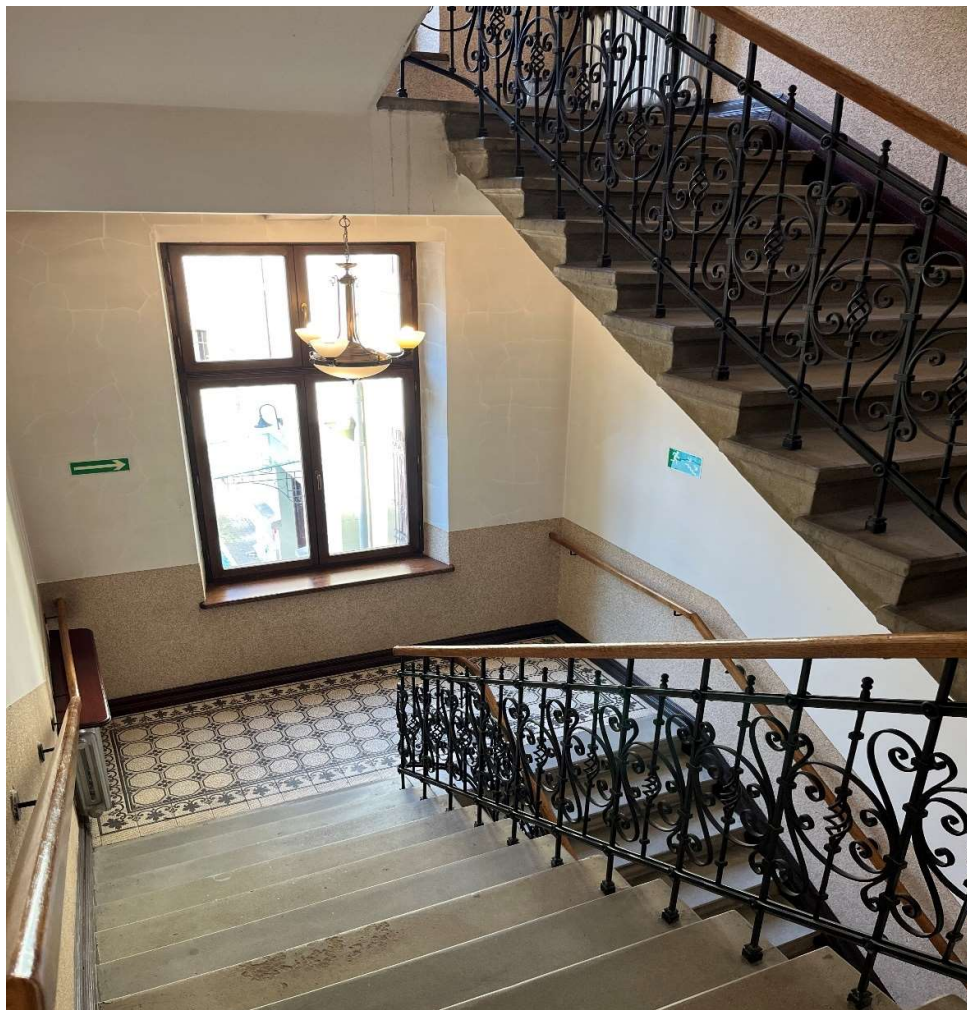
Zdjęcie 9. Schody wewnątrz budynku
