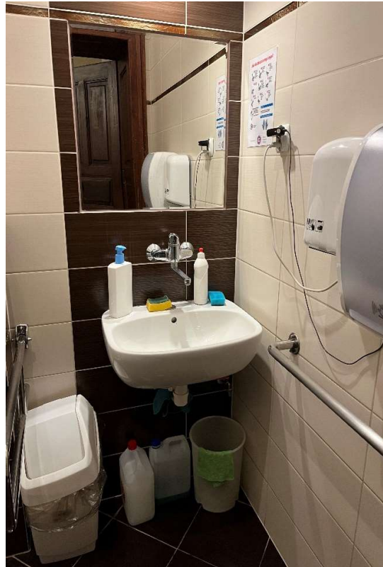
Zdjęcie 8. Umywalka i podajniki zamontowane na ścianie
