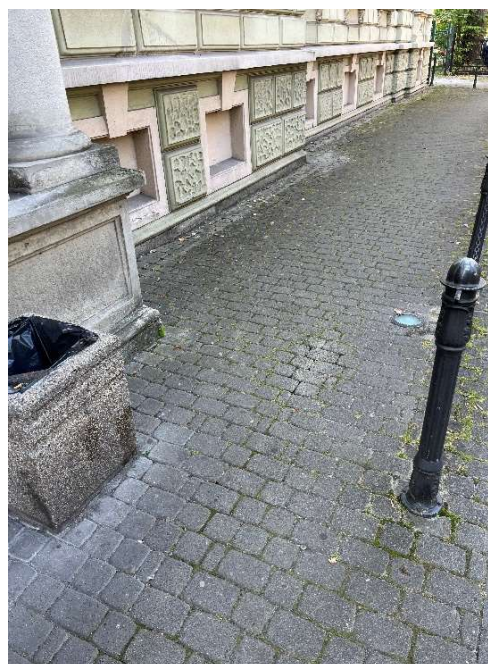
Zdjęcie 2. Elementy utrudniające poruszanie się chodnikiem
